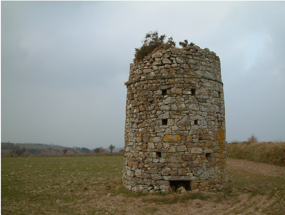
La masse de Digulleville, vue du sud (B. Canu, mars 2006).
